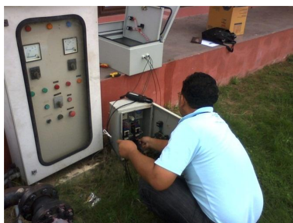
รูปที่ ๑๔ การทดสอบชุดควบคุมกับเครื่องกลเติมอากาศมูลนิธิชัยพัฒนา
