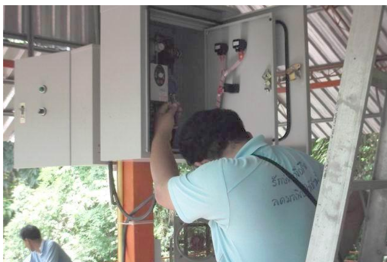
รูปที่ ๑๕ การติดตั้งชุดควบคุม ณ วัดป่าเชิงเลน
