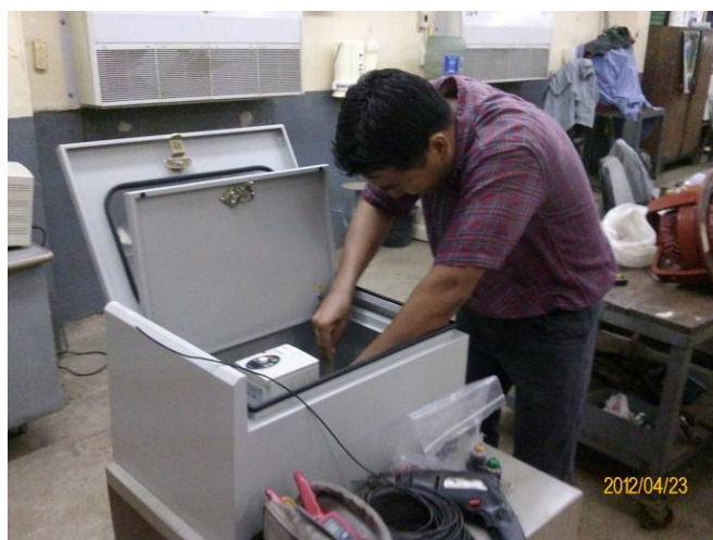
รูปที่ ๑๑ การประกอบชุดควบคุม
