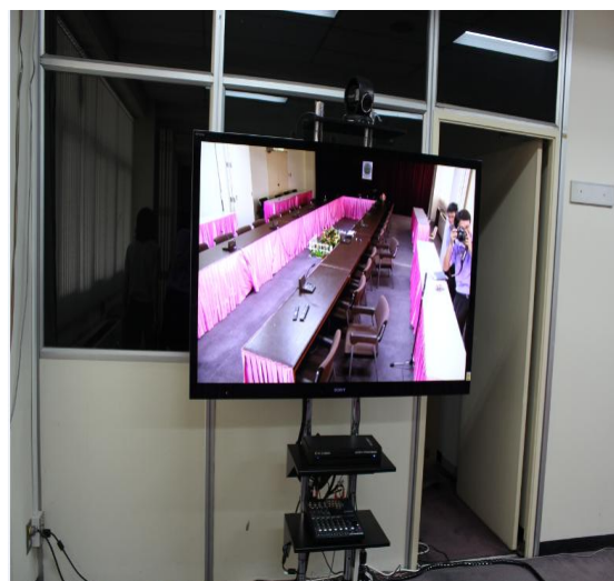
รูปที่ 7 แสดงจอภาพ การเชื่อมต่อระบบกับอุปกรณ์เครื่องเสียงภายในห้องประชุม 300
